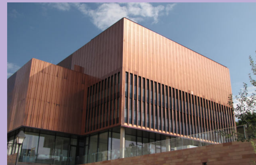
Außenansicht auf das Archivgebäude, BS 9.7.0002 - 10.005, Foto: Marion Tonke
